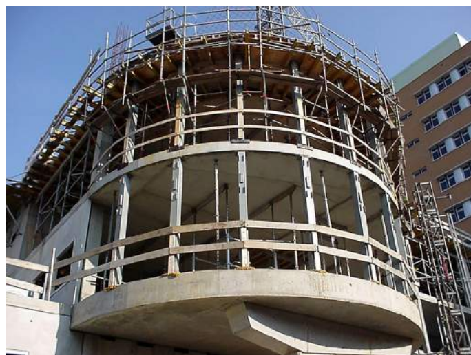
De nieuwbouw van DCG in volle gang in 2005
