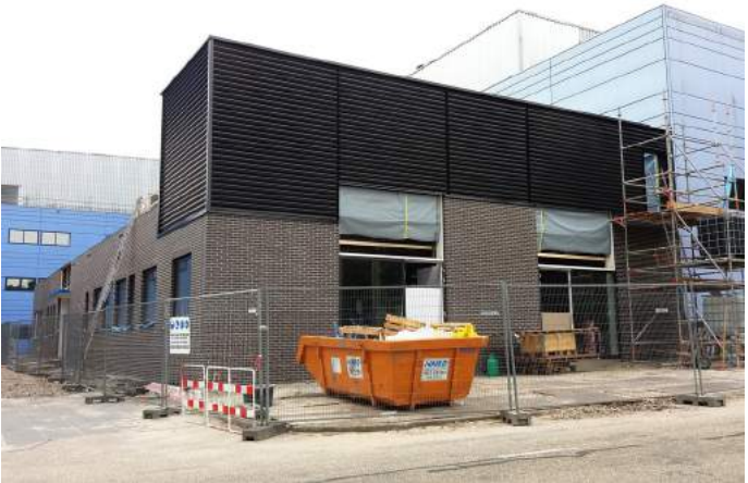
De nieuwe dependance in Assen in aanbouw in 2018
