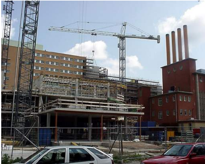
De nieuwe locatie Groningen in aanbouw in 2005
