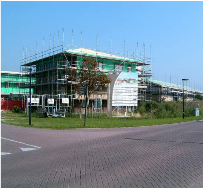
Locatie Midland in aanbouw
